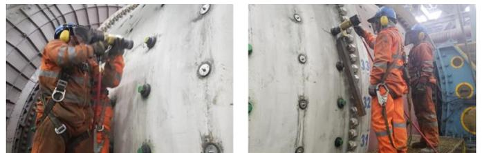
Figura 11. Trabajo con revestimientos con sujeción exterior (Situación actual)
