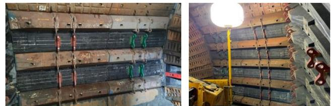
Figura 23. Instalación 1er Set Revestimientos Híbridos.
