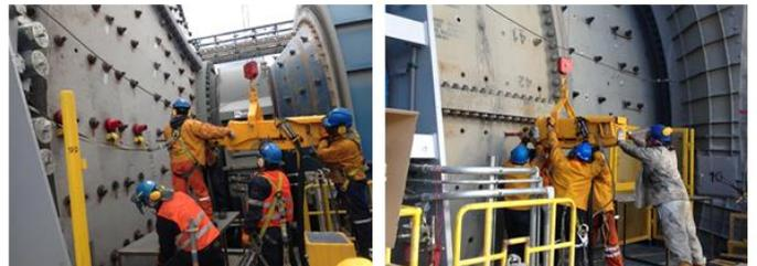
Figura 10. Trabajo con piezas fundidas y sujeción interior (Situación anterior)
